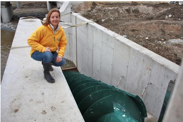
*Stromversorgung aus der eigenen Wasserkraftschnecke hinter der Mühle (2013)*
