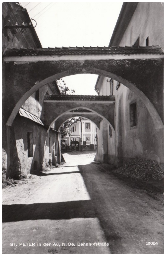
ehemalige „Bahnhofstraße“ mit drei Bögen (1932)
