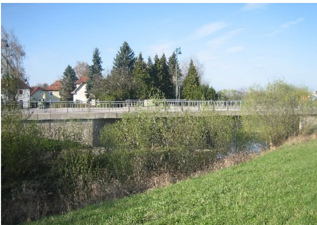
neue Brücke über die Url (2012)
