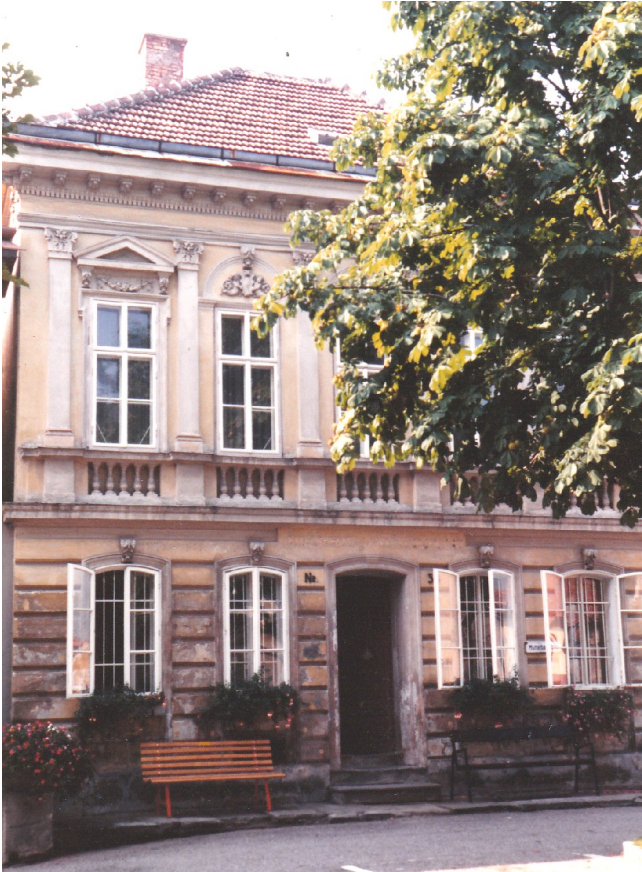
Dürrer-Haus Nr. 38 vor der Sanierung (ca. 1990)
